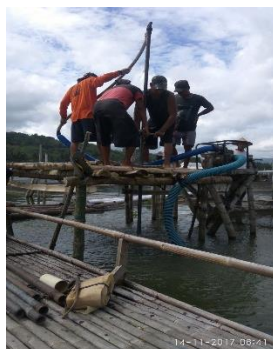
Gambar 6. Pembuatan Sumur Bor di Rowo Jombor dengan Pengeboran Pipa PVC dengan ukuran diameter 4 inci ditanam sebagai casing dalam sumur bor untuk mencegah masuknya air ke dalam sumur bor. Hal ini bertujuan agar air yang disemprotkan ke karamba benar-benar air bersih. Pengerjaan pemasangan casing pipa PVC seperti pada Gambar 7.
