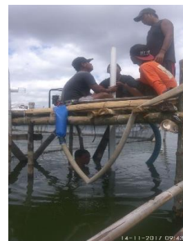
Gambar 6. Pembuatan Sumur Bor di Rowo Jombor dengan Pengeboran Pipa PVC dengan ukuran diameter 4 inci ditanam sebagai casing dalam sumur bor untuk mencegah masuknya air ke dalam sumur bor. Hal ini bertujuan agar air yang disemprotkan ke karamba benar-benar air bersih. Pengerjaan pemasangan casing pipa PVC seperti pada Gambar 7.
