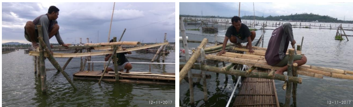
Gambar 4. Pembuatan Lantai Kerja Menggunakan Bambu di Tengah Rowo Jombor untuk Pembuatan Sumur Bor dan Dudukan Pompa Air
