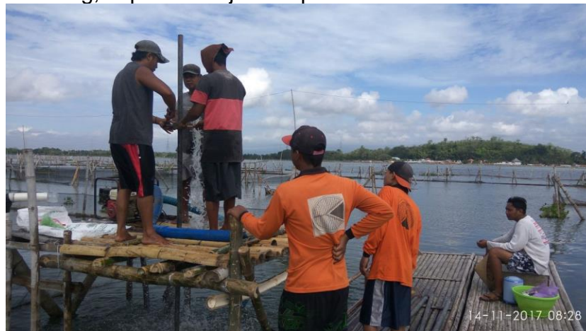
Gambar 6. Pembuatan Sumur Bor di Rowo Jombor dengan Pengeboran Pipa PVC dengan ukuran diameter 4 inci ditanam sebagai casing dalam sumur bor untuk mencegah masuknya air ke dalam sumur bor. Hal ini bertujuan agar air yang disemprotkan ke karamba benar-benar air bersih. Pengerjaan pemasangan casing pipa PVC seperti pada Gambar 7.
