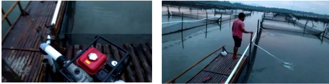
Gambar 9. Instalasi Jaringan Pipa PVC untuk Penyemprotan di Karamba
