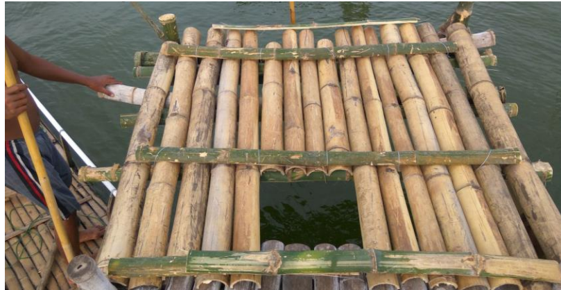
Gambar 5. Lantai Kerja dan Dudukan Pompa yang Terbuat dari Bambu
